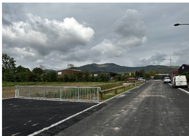
2 ème tranche du Wasen à Dambach-la-Ville
