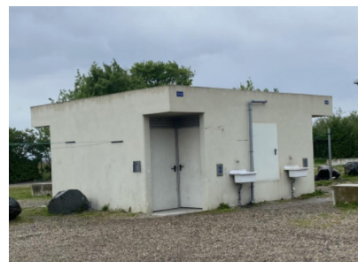
État initial avant travaux
