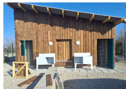
État d'avancement sur le Pavillon 1 er au 28 Mars 2025
