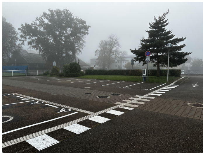
Déraccordement des réseaux EP - Jardin des Sports à Barr
