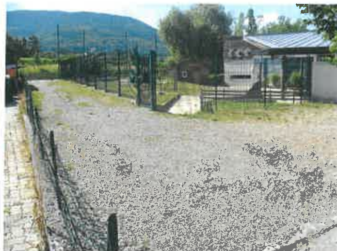
Cour de l'école maternelle avec entrée projet nouvelle école primaire et aire de jeu au fond à déplacer
