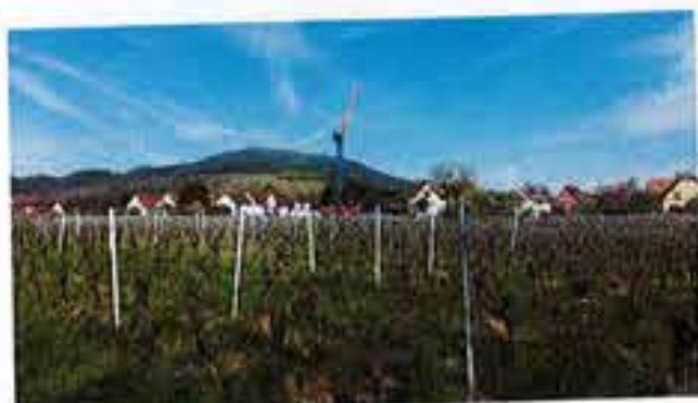
Vue secteur Bodenreben : (immeubles 63 logements en cours)
