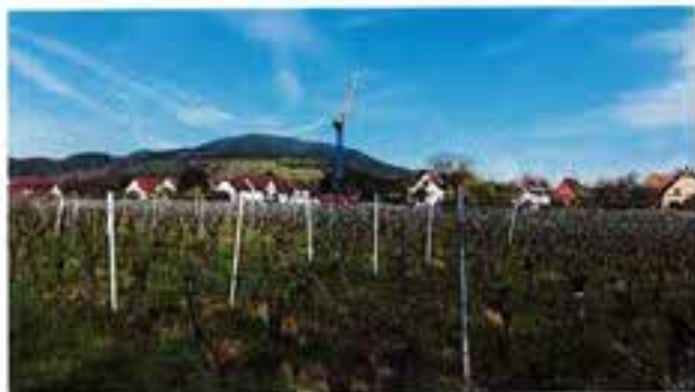
Vue secteur Bodenreben : (immeubles 63 logements en cours)
