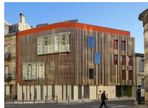
Équipement hybride en centreville : studio de danse et conservatoire installé sur deux anciennes parcelles d'échoppes, Bordeaux
