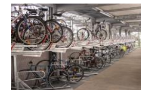
Abri vélos sécurisé Gare de Grenoble
