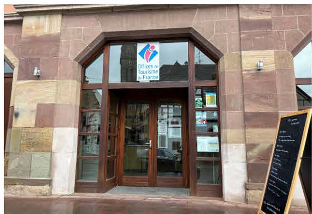
Entrée du bâtiment
