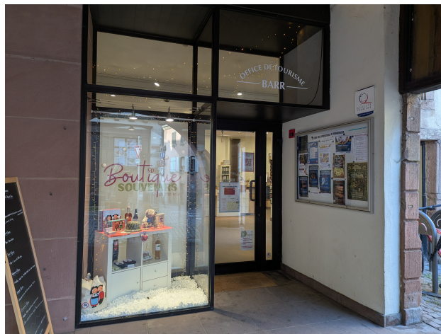
Entrée accessible aux personnes à mobilité réduites (6 rue des Bouchers)
