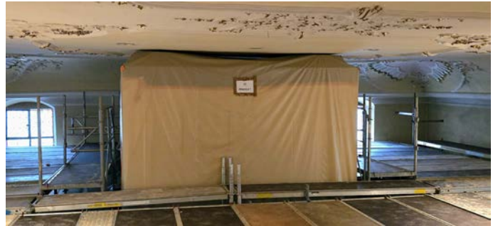
Vue de l'orgue depuis l'échafaudage supérieur
