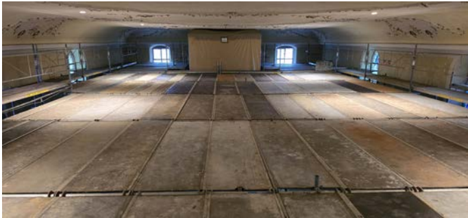
Vue depuis l'échafaudage supérieur du chœur vers le fond de l'église
