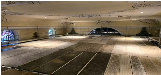
Vue depuis l'échafaudage supérieur du fond de l'église vers le chœur
