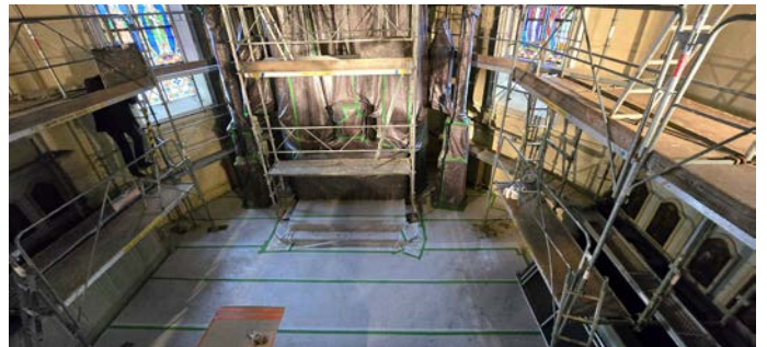
Vue sur le chœur depuis l'échafaudage supérieur
