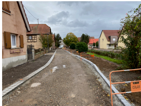
Mise en place des cheminements en pavés de granit et création des places de parking et des bordures végétales
