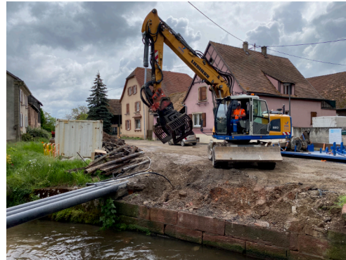
Le pont démoli, les conduites de gaz et d'électricité ont été remises en place et le tablier du pont a été reconstruit
