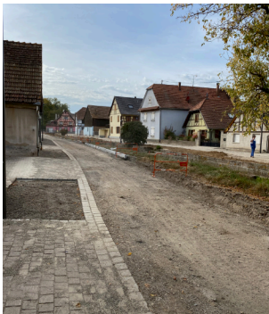
Mise en place des cheminements en pavés de granit et création des places de parking et des bordures végétales
