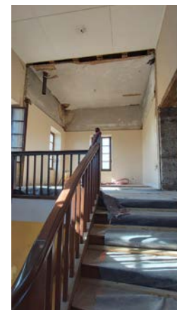
Escalier et pièce en montant l'escalie
