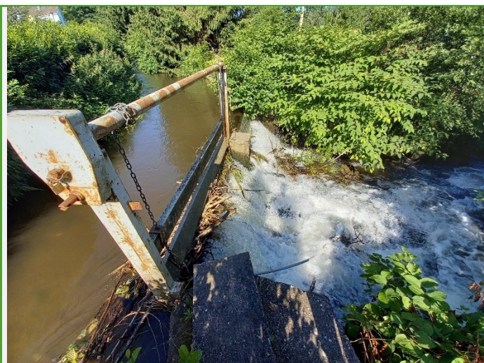
Juillet : Travaux de Fauche contribuant à la dissipation des crues Suivi des cours d'eau / surveillance des ouvrages à la suite des crues estivales et dégagements d'embâcles
