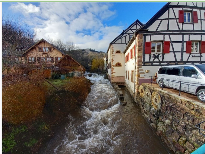
Février : Travaux d'entretien pluriannuel de la Scheer Suivi des cours d'eau / surveillance des ouvrages à la suite des crues hivernales et dégagements d'embâcles
