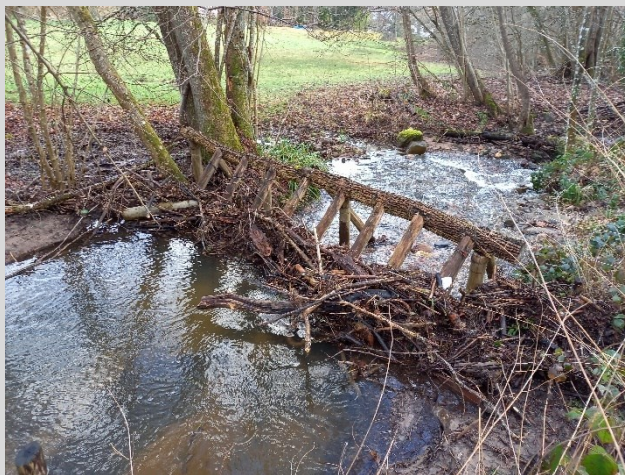
Dégagement d'un piège à embâcle lors des tournées de surveillance après les crues (ouvrage à Barr)
