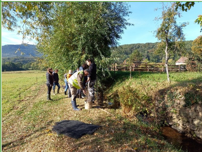
Octobre : Chantier participatif de plantation à Boersch avec une classe de BTS Aménagement du Lycée Agricole de Wintzenheim
