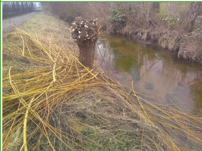
Mars : Travaux d'entretien pluriannuel de la Scheer Travaux d'entretien des boisements de berge (étêtage des Saules)
