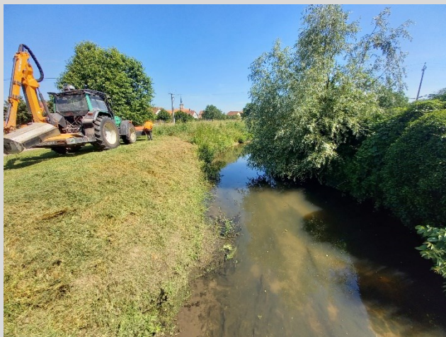
Fauche Mécanique de la Digue de l'Ehn à Geispolsheim
