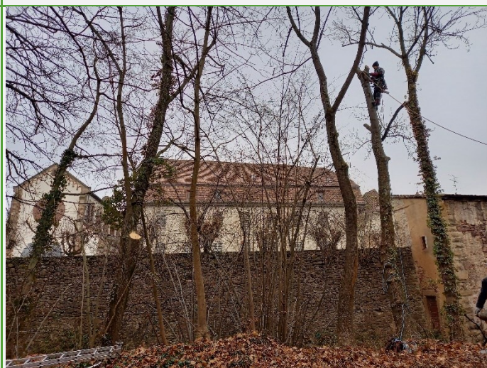
Décembre : Travaux d'entretien des boisements de berge Démontage / abattage de sécurité, d'arbres implantés en bordure de l'Ehn, à côté du Groupe Scolaire « Freppel » d'Obernai
