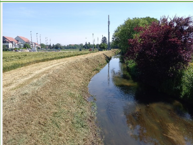
Juin : Travaux de Fauche contribuant à la dissipation des crues et surveillance des ouvrages (Digue de l'Ehn à Geispolsheim)
