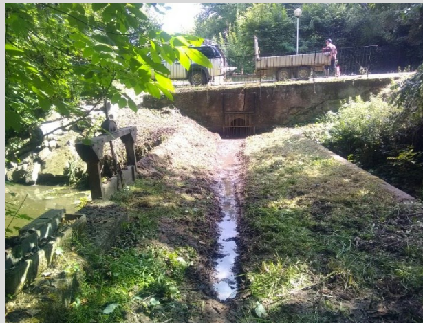
Décapage des sédiments sur un ouvrage de l'Ehn à Obernai pour maintenir l'écoulement vers le Parc de Hell
