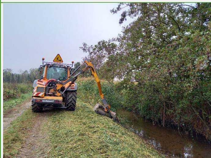
Novembre : Travaux de Fauche contribuant à la dissipation des crues Canal de décharge de l'Ehn à Krautergersheim
