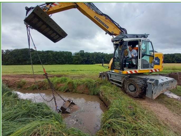
Août : Travaux de décapage d'atterrissements sur la Schernetz à Epfig et sur la Kirneck Valff
