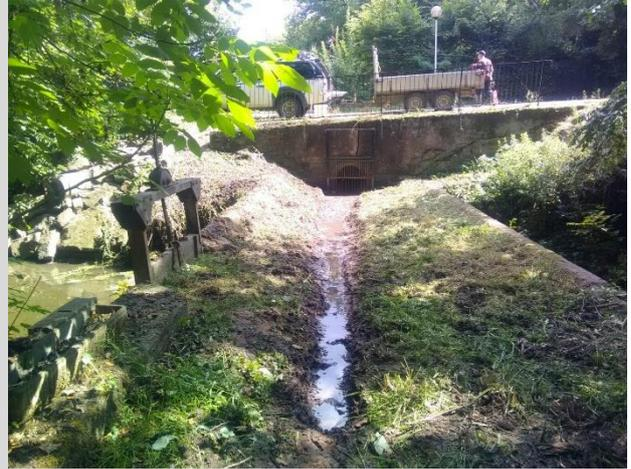
Décapage des sédiments sur un ouvrage de l'Ehn à Obernai pour maintenir l'écoulement vers le Parc de Hell
