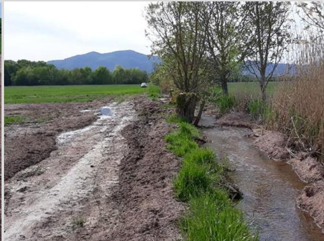
Décapage des sédiments déposés en Rive Droite sur le Chemin d'exploitation et création d'une annexe hydraulique vers la roselière
