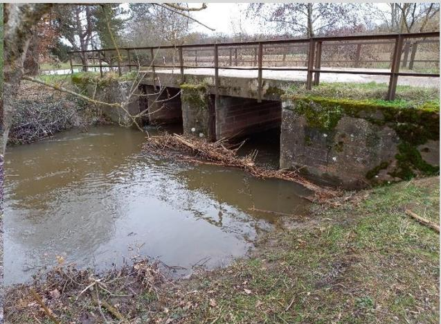
Embâcle formé au niveau d'un pont à pilier sur l'Andlau à Zellwiller
