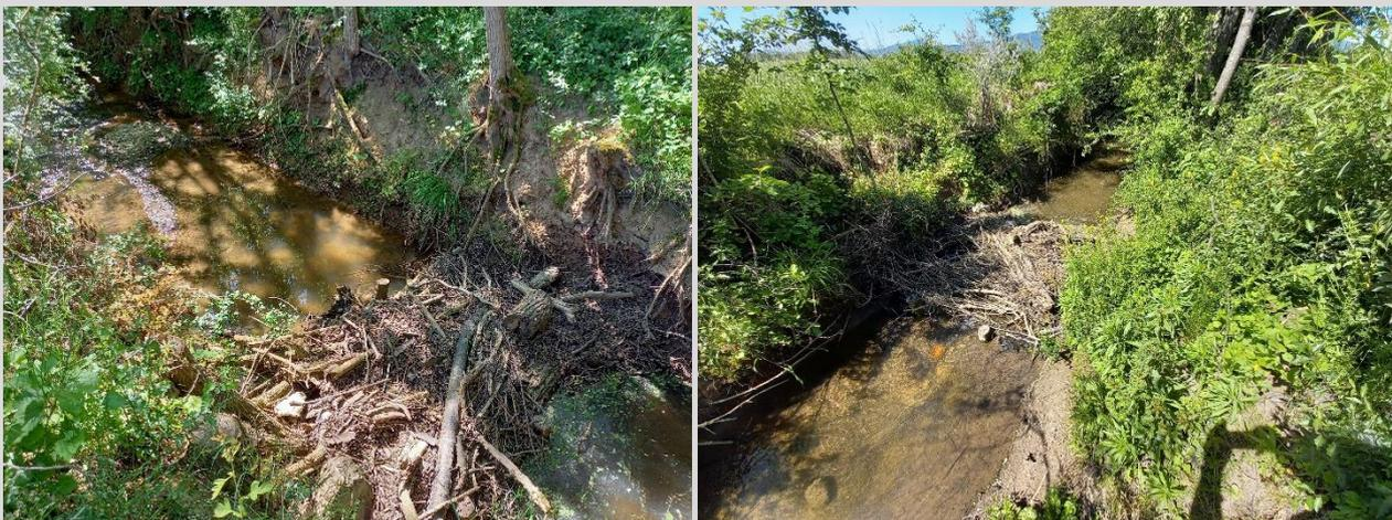
Réalisation d'une succession de 5 seuils dans le lit du Dachsbach
