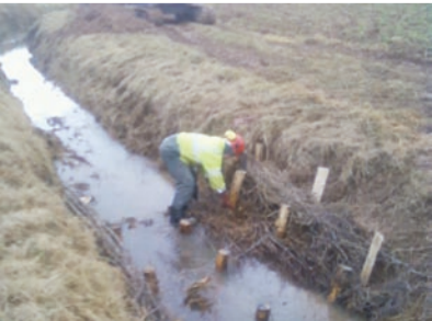
Installation d'une protection de berge en technique végétale
