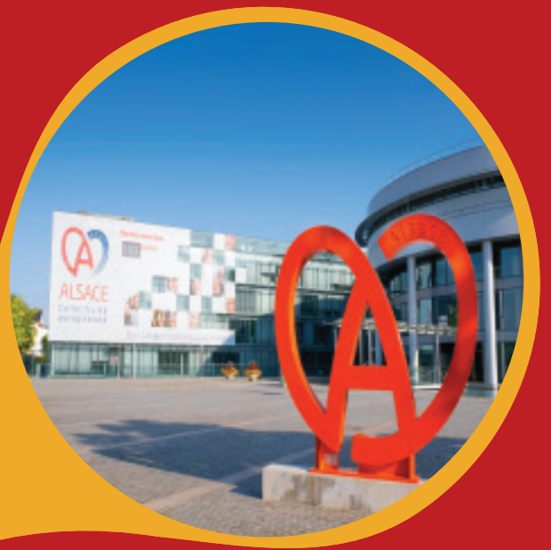
Conseil départemental du Haut Rhin avec le compte à rebours avant création de la CEA, le 1 er janvier 2021.
